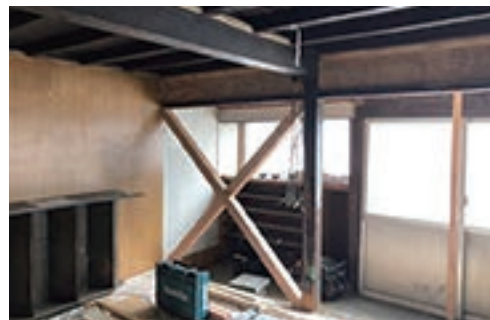
耐震筋交いを入れた (2020年4月)
