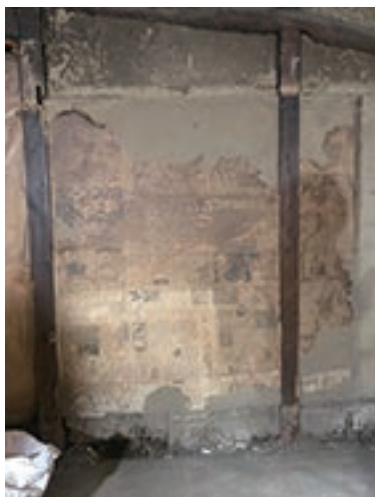
壁を剥がしたら昭和13年4月の新聞が現れた！
