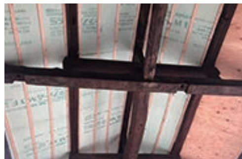
天井断熱材を入れる (2020年4月)
