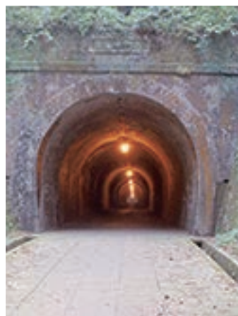
明治宇津ノ谷トンネル
