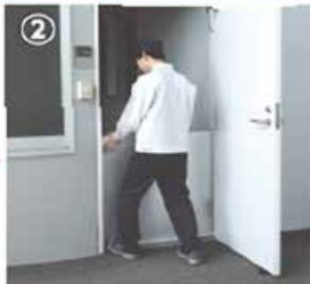
② ラクセットSDタイプをドア枠にはめ込み、上から押しつけます。
