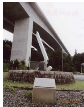
新名神高速道路起工地跡
