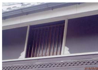
窓枠のシッキイに職人魂が見られる
