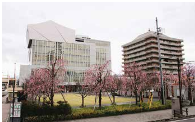
長野市役所第一庁舎及び長野市芸術館 2015年 竣工
